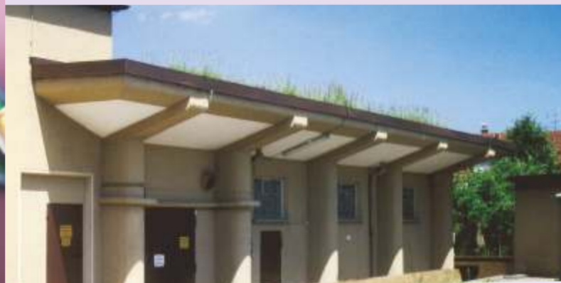
Letzter erhaltener Trocknungsbunker mit Gras bewachsenem Flachdach
